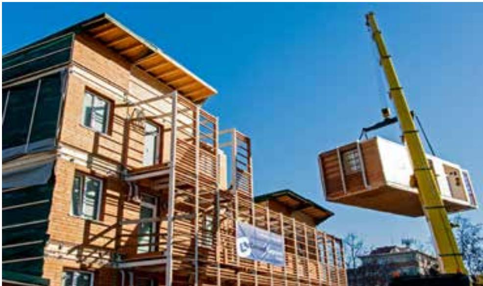
**Fig.2** *Una fase del cantiere con il sollevamento e la movimentazione di uno dei moduli prefabbricati che compongono le abitazioni sociali.*
