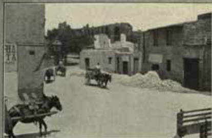
LE DEMOLIZIONI ALL'ARCO DI SEPTIMIO SEVERO
