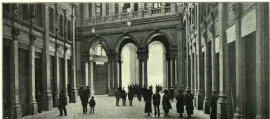
Vista delle due branche della nuova Galleria.
